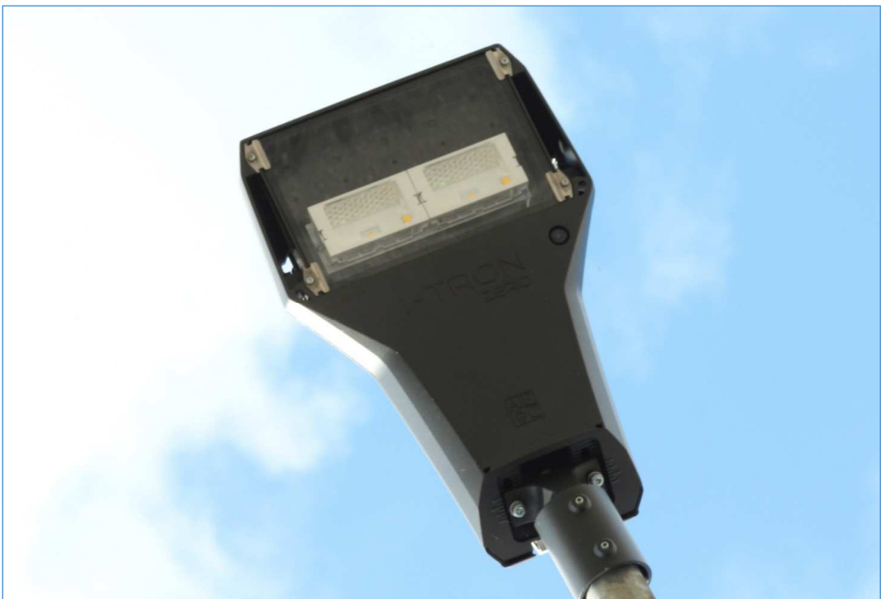
Figura 1 – Immagine di uno dei nuovi lampioni a LED di Loiano sulla SS 65 della Futa. Il lampione è dotato di due moduli a LED (i LED sono i quadratini di colore giallo) e ne può ospitare fino a 4, ben visibile la scritta I-TRON zero che identifica il modello della ditta AEC. Crediti: A. Carbognani.
